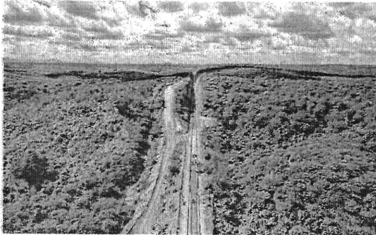
VISTA aérea das obras da ferrovia Transnordestina em Iguatu, no Ceará
