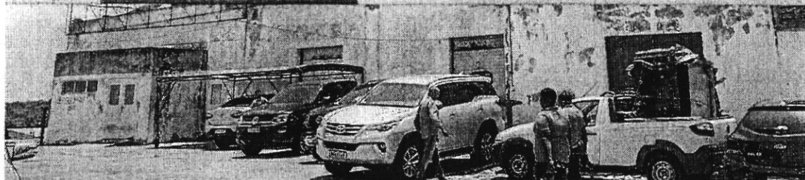
ESTRUTURA do Terminal Pesqueiro do Porto de Camocim necessita de revitalização
